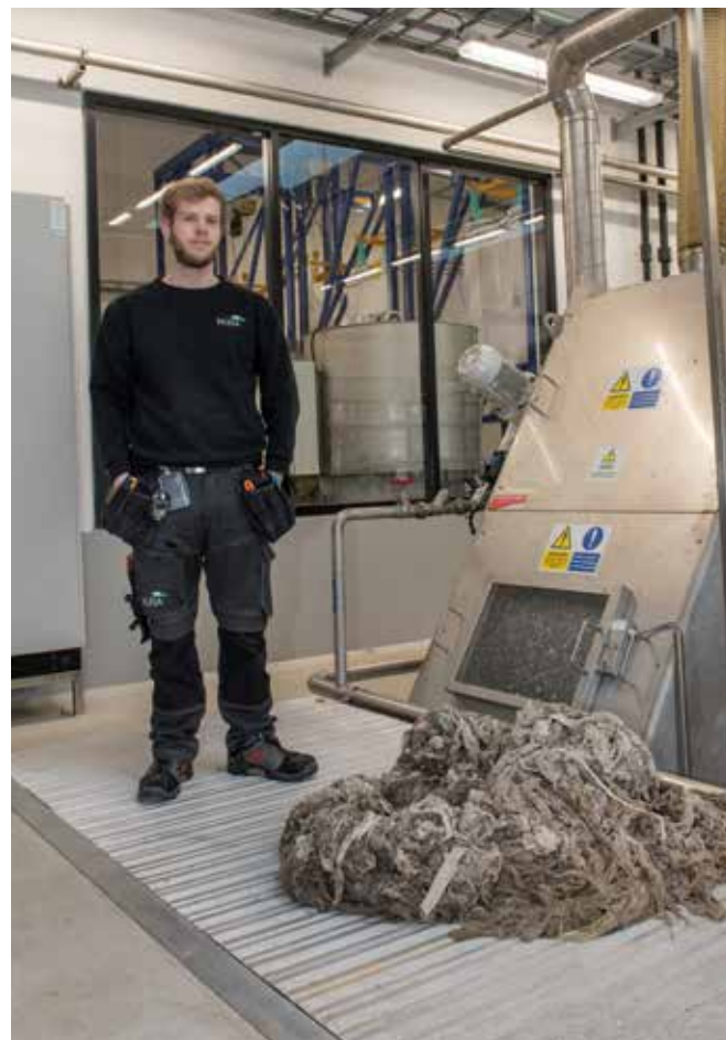
Filler og avfall som kastes i avløpet tas ut av avløpsristene til Tangen RA.
