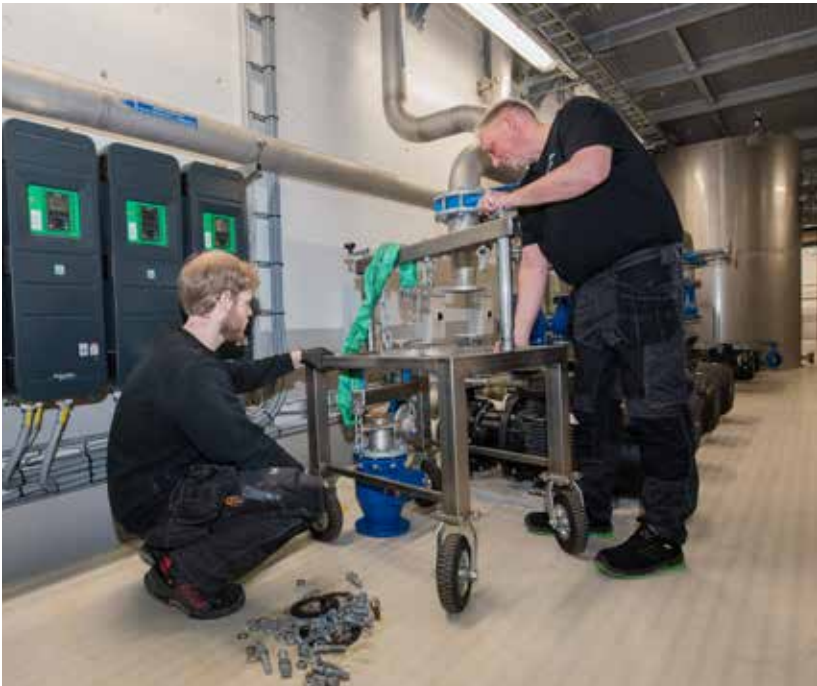
Vedlikehold og ettersyn av anlegg.
